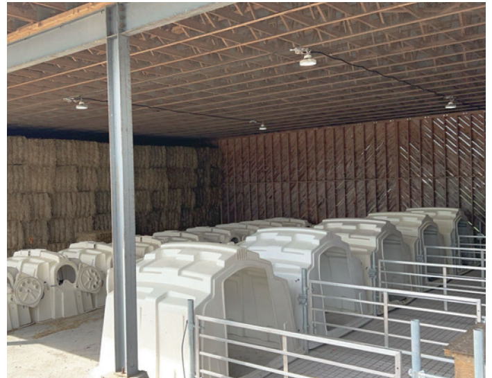
Le bâtiment trois côtés qui abrite les huches à veaux depuis 2023 afin de protéger les veaux et les travailleurs contre les intempéries.
